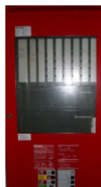
Ancienne centrale de détection Cerberus CZ10
